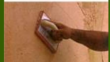
Il rivestimento a calce naturale presenta vantaggi rilevanti: è in grado di creare un tenace legame chimico, piuttosto che meccanico, con i blocchi di argilla, con l'effetto di una grande durabilità; ma soprattutto – diversamente dagliintonaci premiscelati grazie alla grande capacità di assorbire e restituire umidità e ad una permeabilità al vapore prossima a quella del laterizio, presenta una elevata traspirabilità e valori minimi di ritenzione d'acqua.
