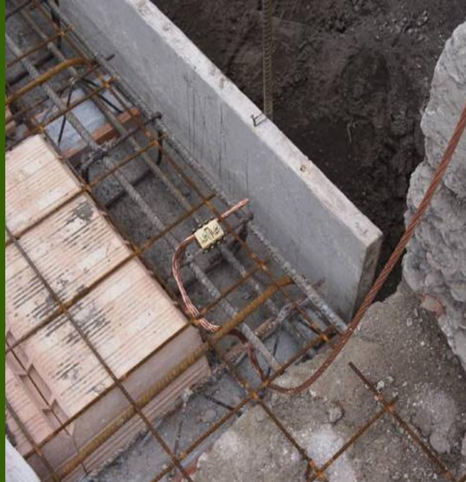
Indipendentemente dalla tipologia è bene inserire sempre un nastro d'acciaio o una treccia di rame nelle fondazioni perimetrali, in modo che funzioni da dispersore al quale si possono collegare tutti gli elementi in ferro della costruzione e degli impianti (tubazioni, radiatori, ecc.) Con questa "messa a terra" si riduce notevolmente l'intensità dei campi elettrici ed elettromagnetici, che si formano attorno alla costruzione, e vengono deviate le correnti vaganti.
