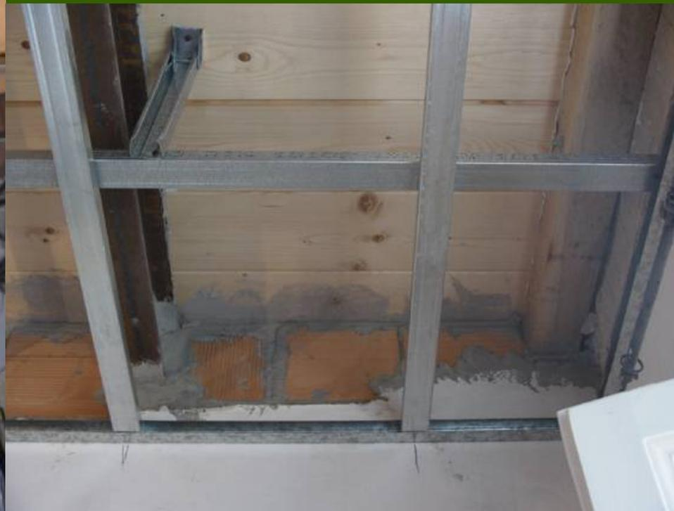
Per proseguire il sistema a secco per le tamponature e per realizzare i bagni si è utilizzato il cartongesso sul secondo strato di legno che costituisce la pavimentazione.
