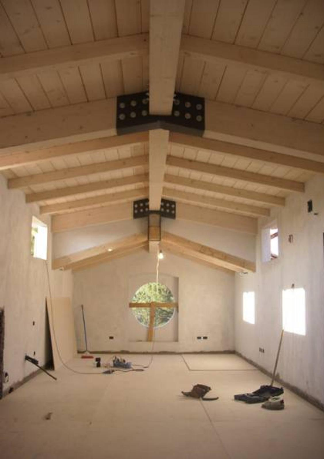
La vecchia soffitta per essere trasformata in camere doveva soddisfare i requisiti antincendio, così il tavolato portante realizzato in due strati incrociati è stato protetto con lastre di calcio silicato. Posato il primo strato di tavolato da 6 cm e due strati di calcio silicato si è posato il secondo strato di tavolato in larice da 3,5 cm. In questo modo si è raggiunta la resistenza al fuoco da “sopra”.
