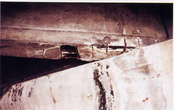
L'ossidazione delle armature porta rapidamente alla perdita di capacità portante.
