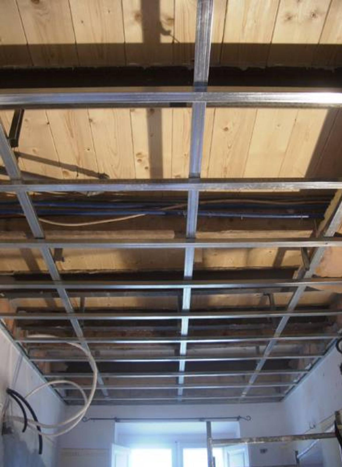
Per ottenere anche la resistenza al fuoco da “sotto” del solaio, presente solo nel disimpegno del piano sottostante, si è realizzato un controsoffitto con struttura nascosta e continua. I pannelli sono resistenti all'umidità, all'urto ed all'invecchiamento. La ditta fornitrice ha dovuto rilasciare i certificati su misura.
