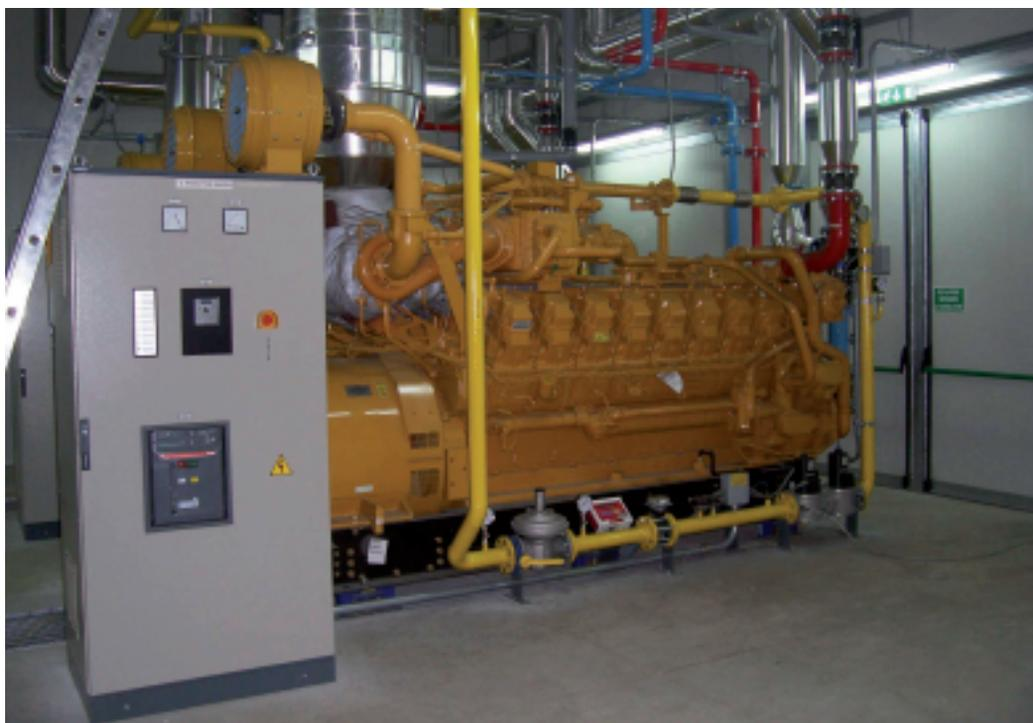
Figura 10 - Motore a combustione interna in una centrale di cogenerazione.
