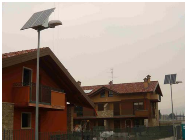
Figura 17: Lampade a luce diretta con pannello fotovoltaico
