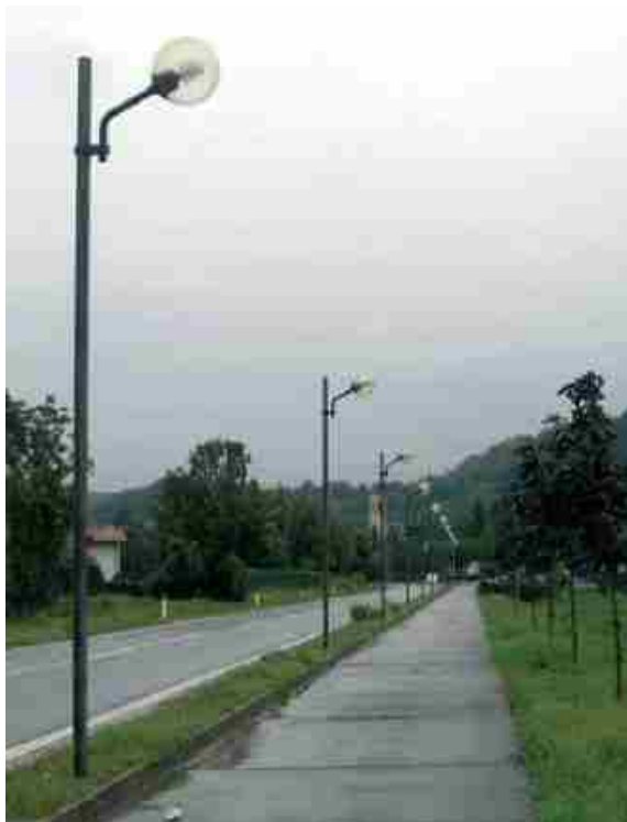
Figura 52 - Esempio di illuminazione stradale da evitare.
