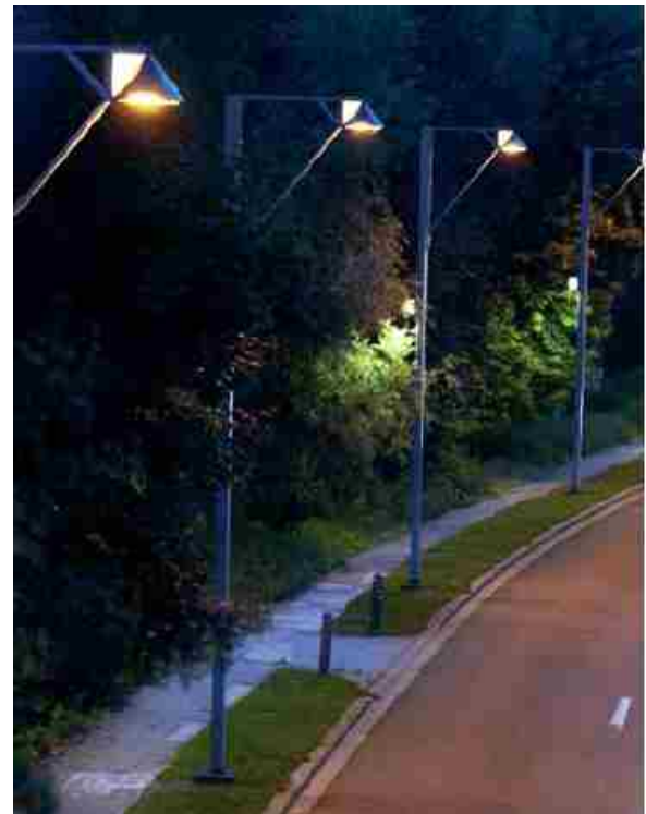
Figura 53 - Un buon esempio di illuminazione stradale
