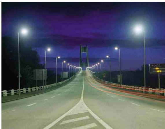
Figura 9 - Accesso ad un ponte (foto Philips)
