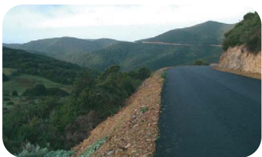
Fig. 2.10. Una strada forestale nella zona di Arbus (Cagliari): si nota l'evidente interruzione del profilo di versante (foto: Ambiente Italia s.r.l.)
