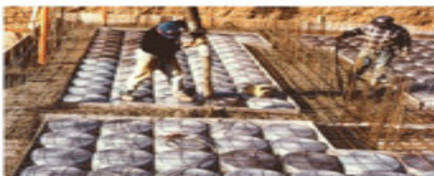
Posa in opera del solaio creato
