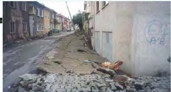
Liquefazione e cedimenti permanenti
