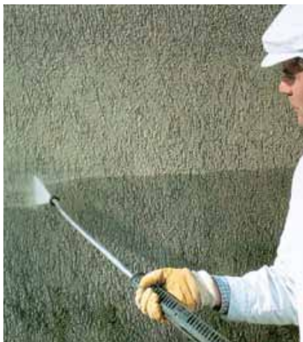
Fig. 10 Intervento preparatorio su una superficie colonizzata
