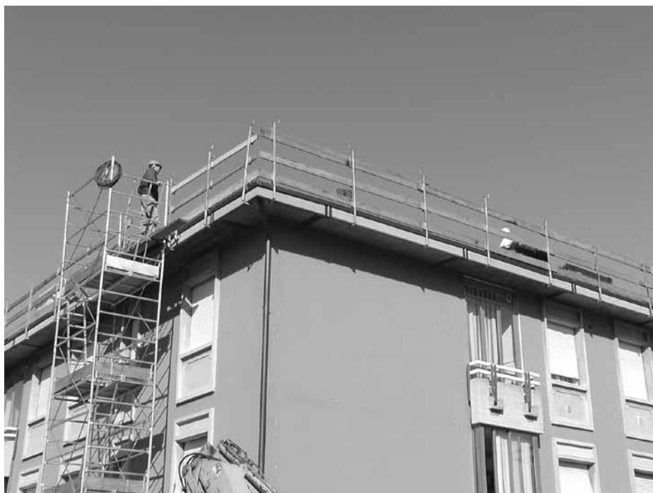
Sistemi provvisori di protezione bordi tetti
