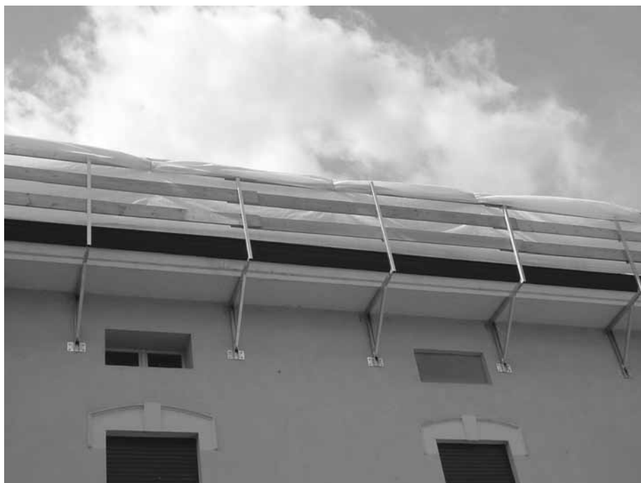
Sistemi provvisori di protezione bordi tetti
