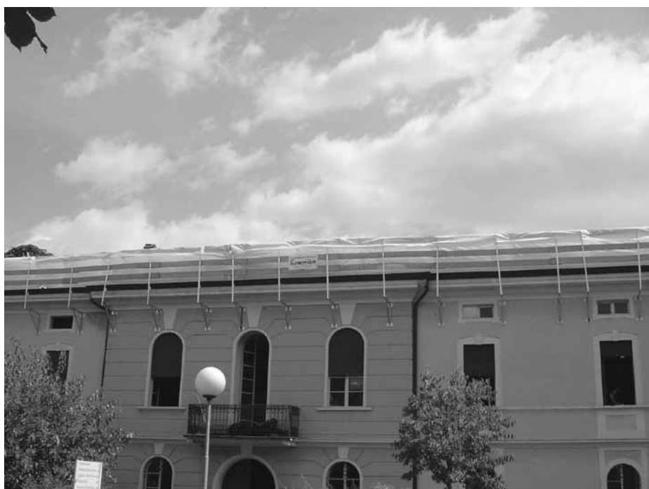
Sistemi provvisori di protezione bordi tetti
