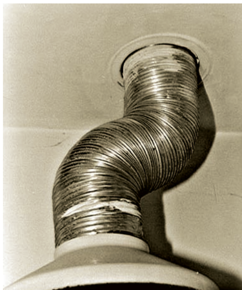
8.27 - Condotti flessibili corrugati non idonei per stato di mantenimento e conformazione
