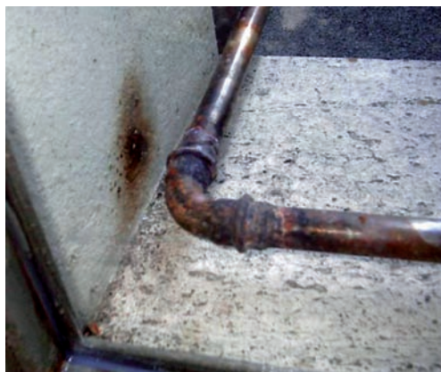
8.23 - Giunzione inidonea perché in esecuzione brasata anziché a pressare come necessario in relazione al tipo di raccordo presente
