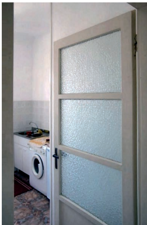
19.7 - Esempio di porta munita di vetri non infrangibili
