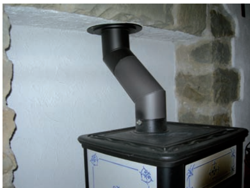
11.23 - Attenzione alle curve delle canne fumarie
