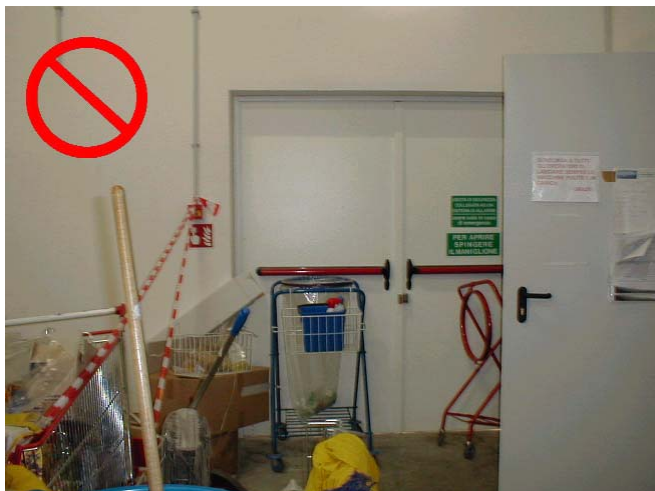
Vie d'emergenza ostruite da materiali
