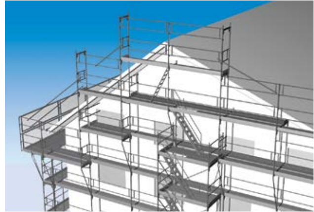
Figura 1 protezione collettiva durante la fase dei lavori di costruzione
