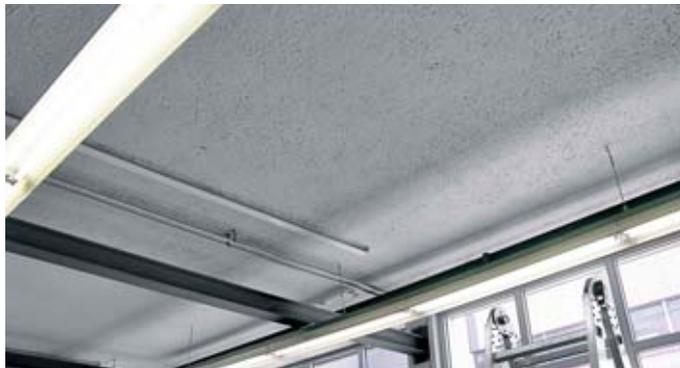
Rivestimento del soffitto in amianto spruzzato
