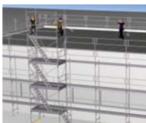
1 Tetto piano con ponte da lattoniere
