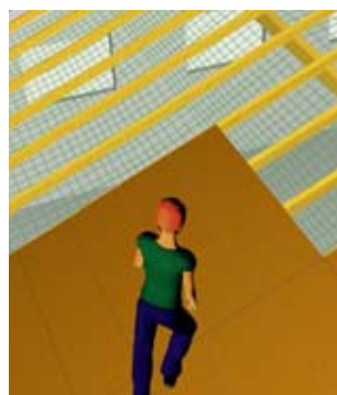
Regola 3 Impedire le cadute verso l'interno dell'edificio
