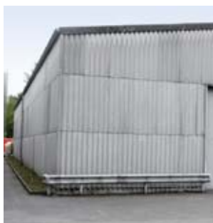
1 Facciata rivestita di lastre contenenti amianto
