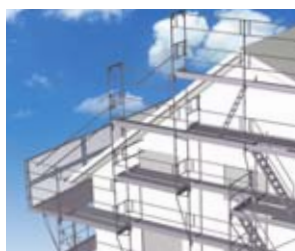
3 Tetto spiovente con ponte da lattoniere e protezione sul lato frontone
