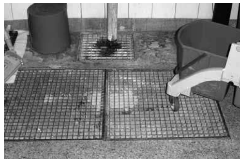
Fig. 1: pavimenti con grigliati a filo dotati di superficie antiscivolo per evitare infortuni.
