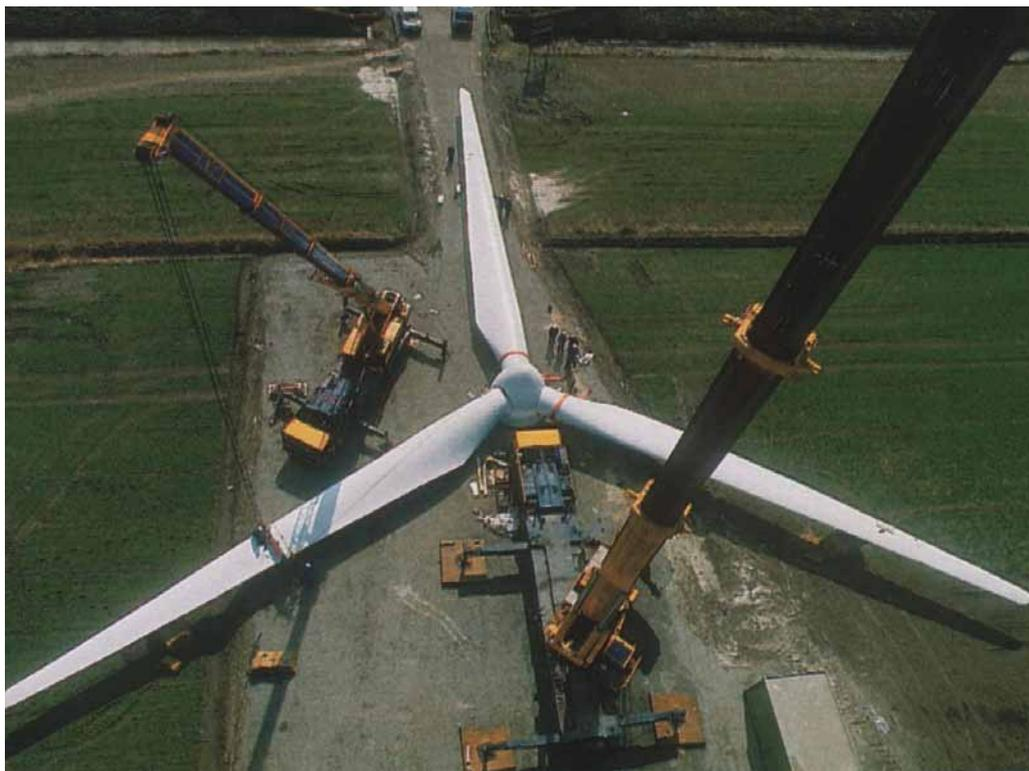
Fig. 2.8: Rotore tripala in fase di montaggio
