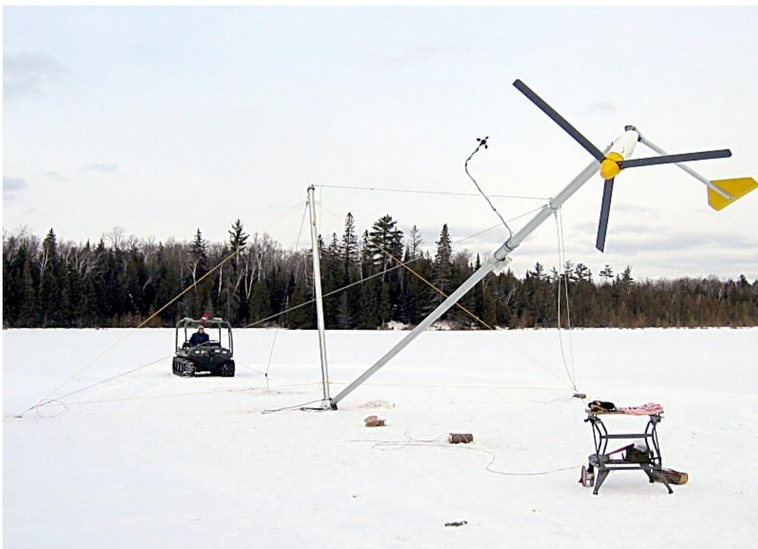
Fig. 3.7: Sollevamento di una torre incernierata mediante motoslitta
