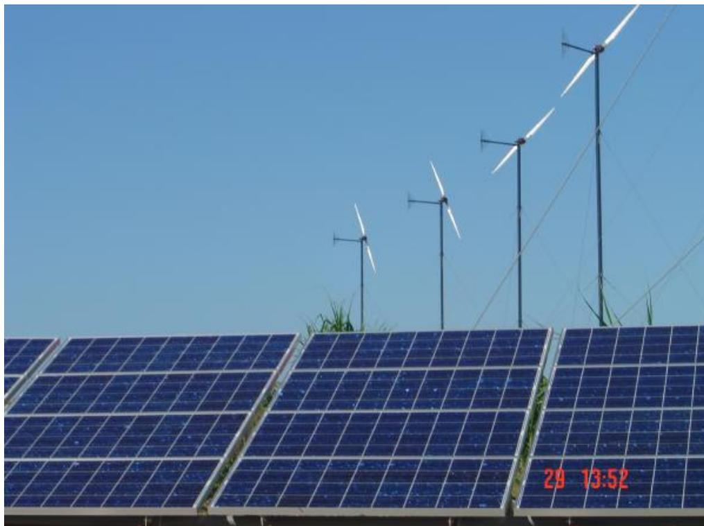
Fig. 3.4: Sistema ibrido eolico-fotovoltaico
