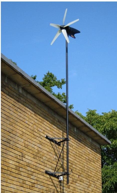
Fig. 3.6: Microturbina installata su un edificio
