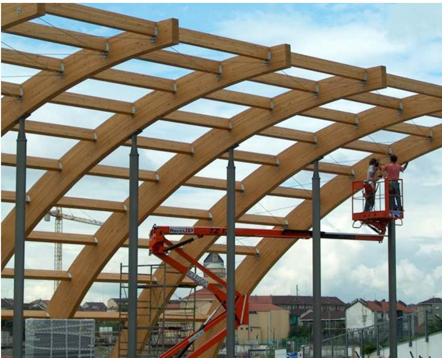
Fig. 3 Struttura in carpenteria metallica e legno lamellare
