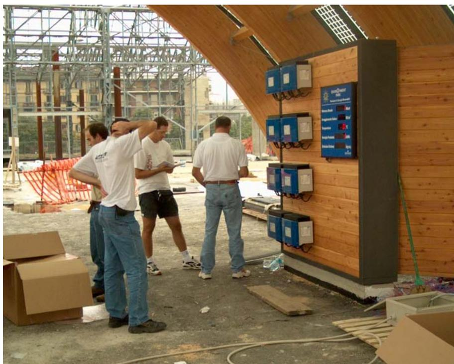
Fig. 6 Armadio inverter al di sotto della vela fotovoltaica
