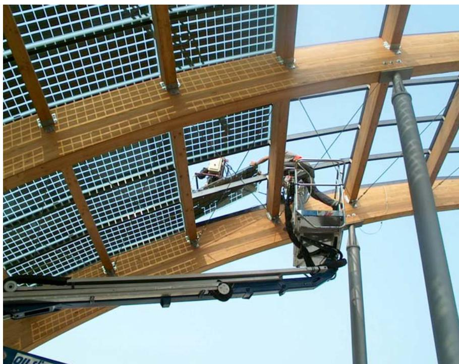
Fig. 5 Montaggio moduli fotovoltaici in vetro/vetro
