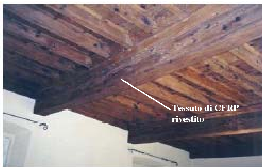
Figura 9-5 –Intervento di rinforzo eseguito sulla trave principale (progettista: ing. G. Ussia – Ardea Progetti e sistemi S.r.l.).
