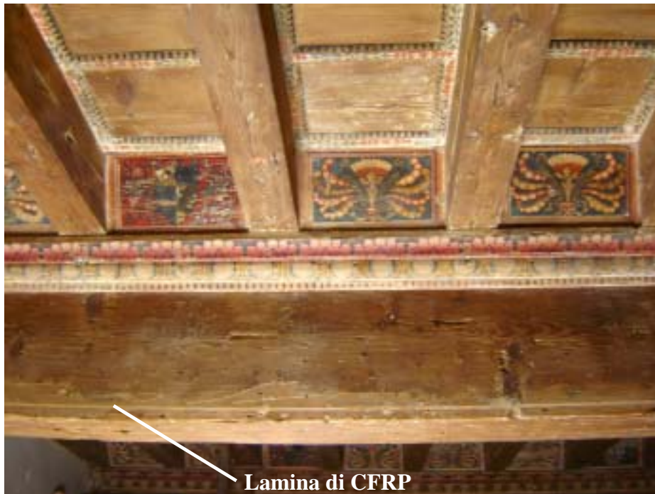
Figura 9-1 – Intervento in palazzo Nobili (progettista: ing. M. Martinelli - Legno Più S.r.l.).
