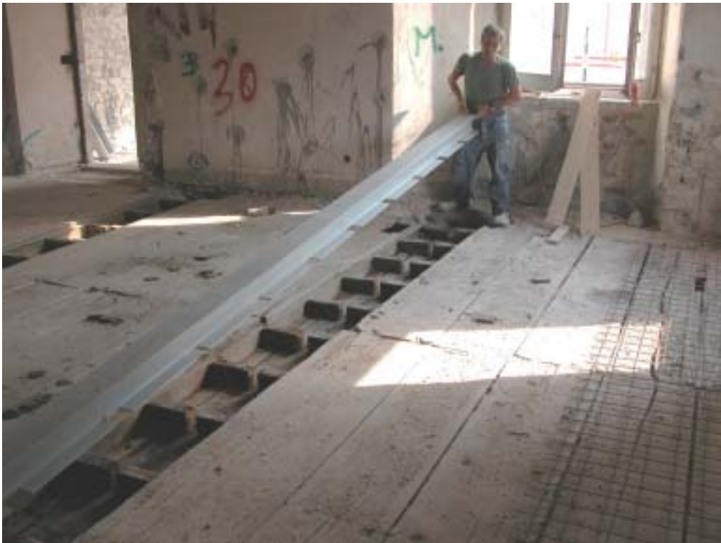
Figura 9-4 –Intervento di rinforzo eseguito sulle travi principali (progettisti: ingg. A. Giannantoni e F. Menghini, in collaborazione con il prof. A. Borri).
