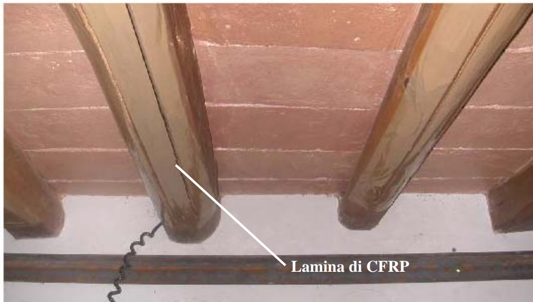
Figura 9-3 –Intervento di rinforzo eseguito sulle travi secondarie (progettista: ing. A. Giannantoni, in collaborazione con il prof. A. Borri).
