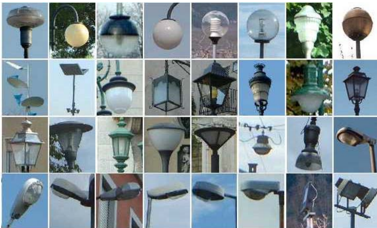
Figura 7 - Esempi di corpi illuminanti non rispondenti ai requisiti delle presenti linee guida e non a norma di Legge Regionale n°37/2000. Non utilizzare questi prodotti per le nuove installazioni
