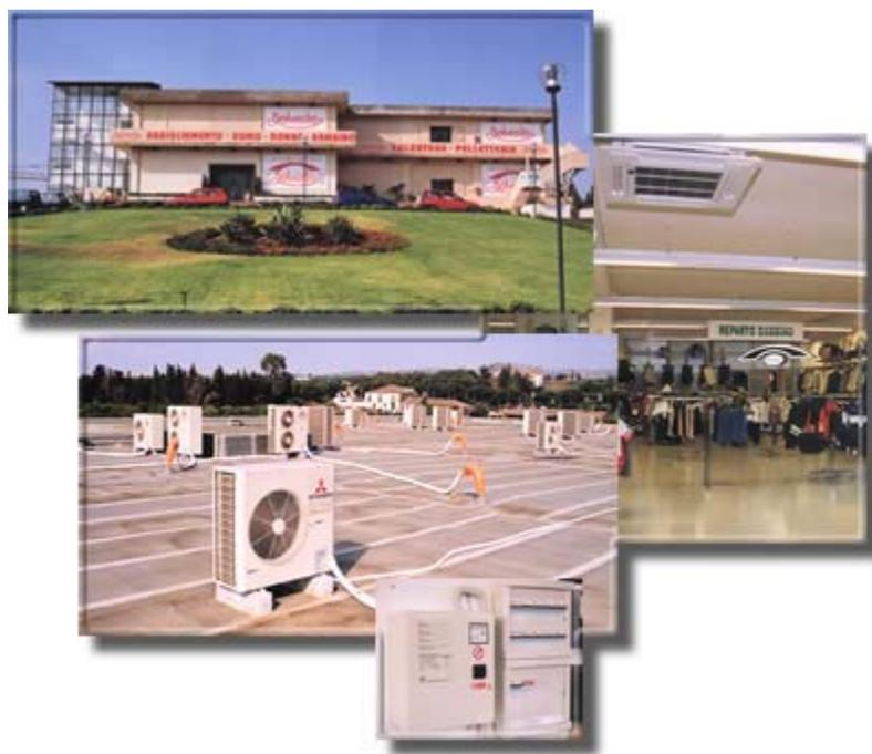
La necessità e la crescente richiesta di comfort abitativo, spingono utenti e progettisti a porre sempre maggiore attenzione alla razionale ed efficiente climatizzazione degli ambienti. In questo contesto, la pompa di calore a ciclo invertibile è un utilissimo strumento in quanto, oltre a permetterci di raffrescare in estate, in inverno, sfruttando per il riscaldamento il calore gratuito esterno, ci consente di risparmiare energia e, quindi, di inquinare meno.
