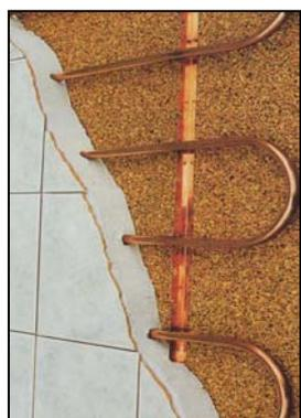
Normalmente il serpentino in rame viene fornito in moduli preassemblati che facilitano la posa in opera degli elementi con un passo, generalmente, di 10 centimetri. Questi vengono posti sulla parete grazie a speciali supporti per fissare il serpentino al muro o all'isolante. L'intonaco può essere supportato dal serpentino stesso.
