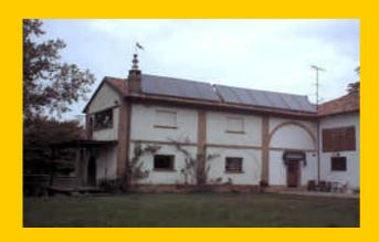
Il campo collettori (23,1 m² di superficie) è montato sul lato ovest dell'edificio di 'Ca del Conte' a Rivanazzano, in provincia di Pavia, utilizzato come seconda casa. L'impianto di riscaldamento deve mantenere durante l'inverno 290 m² di superficie abitabile a una temperatura superiore a quella esterna. In estate l'impianto fornisce acqua calda sanitaria e riscalda la piscina di 68 m³ nel giardino della casa.
