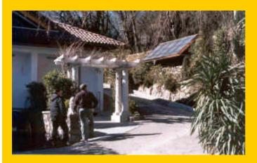
L'impianto solare termico è collocato su un muro del giardino accanto ad una casa unifamilare sita sul lago di Mergozzo, in provincia di Verbania. Il collettore è autocostruito. La sua superficie è di 9,6 m², il volume del serbatoio è di 600 litri. L'impianto produce acqua calda sanitaria durante tutto l'anno. Durante la stagione invernale fornisce calore a una parte dell'edificio attraverso un impianto di riscaldamento a pavimento. In estate riscalda la piscina del giardino, di 48 m³.
