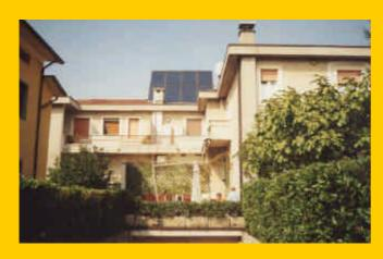
Il campo collettori di 18,5 m² è installato con un'inclinazione di 55° sul tetto di una casa monofamiliare a Paderno Franciacorta, in provincia di Brescia. Il serbatoio tampone ha un volume di 2.000 litri. L'impianto solare termico riscalda un ambiente di 70 m² e fornisce acqua calda sanitaria all'impianto dotato anche di ricircolo. Nel periodo estivo l'impianto fornisce acqua calda anche ad un vicino.
