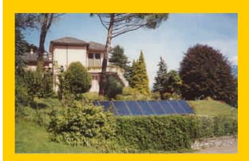
Il campo collettori (20,9 m² di superficie) è collocato nel giardino di una casa per vacanze a Menaggio sul lago di Como. L'impianto solare termico viene utilizzato per mantenere durante l'inverno gli ambienti ad una temperatura maggiore di quella esterna. In estate l'impianto riscalda la piscina, di 82 m³, anch'essa nel giardino della casa.
