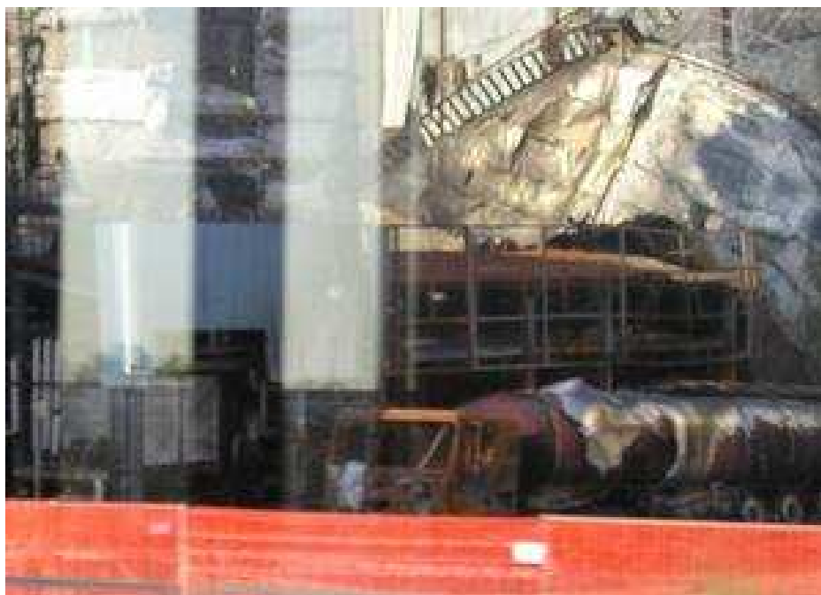
Incendio raffineria Falconara: 1 decesso e alcuni feriti
