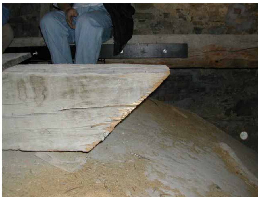
Figura 98. Ricostruzione dell'estremità di trave in legno appoggiata alla parete muraria mediante protesi di testata
