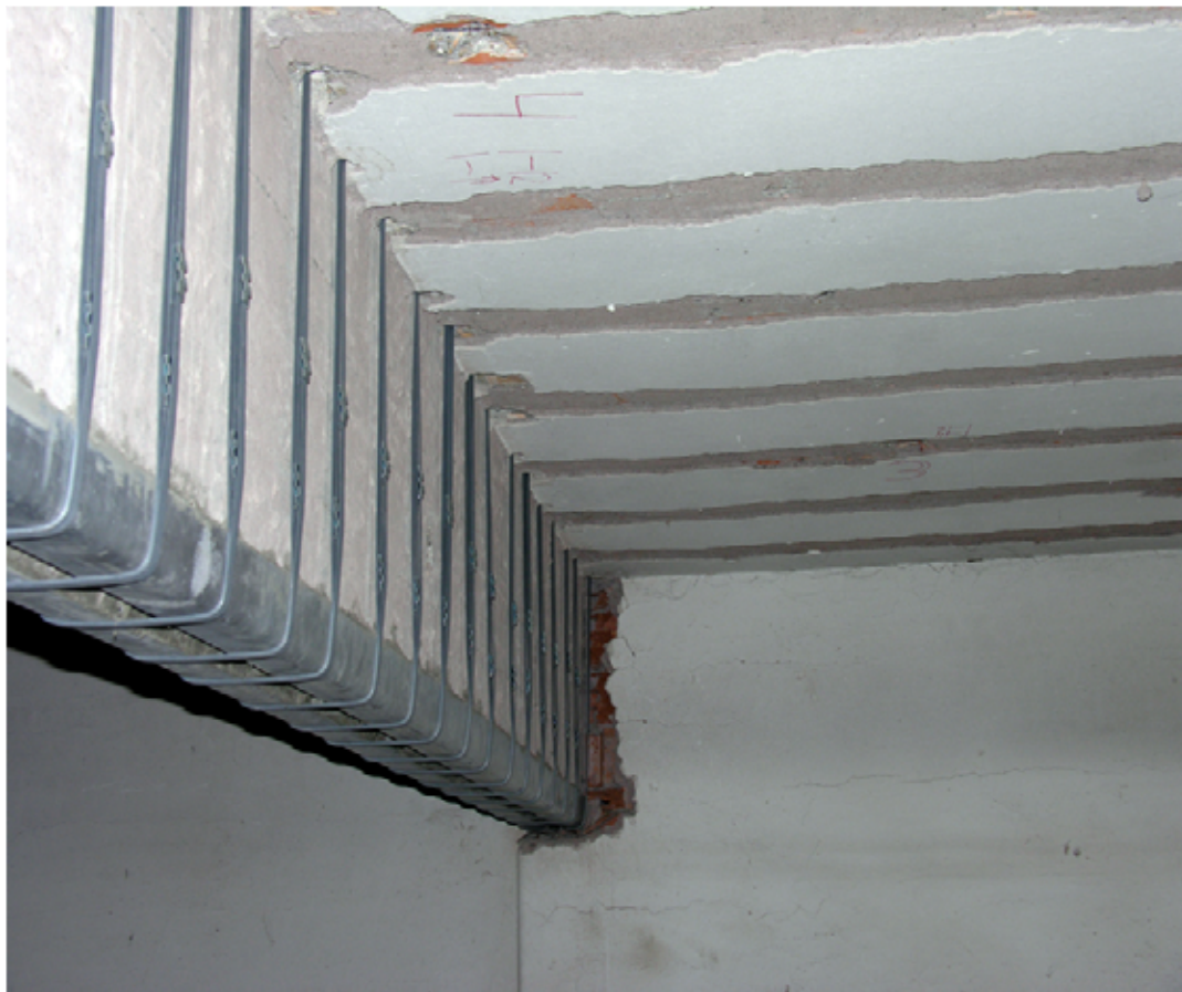
Figura 95. Rinforzo a taglio con nastri pretesi in acciaio ad alta resistenza contrastati su piastre imbutite all'intradosso del solaio
