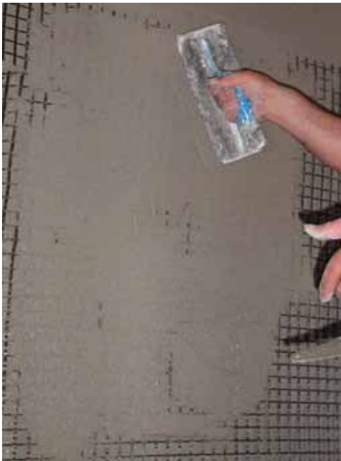
Lisciatura della superficie " fresca " con spatola piana.
