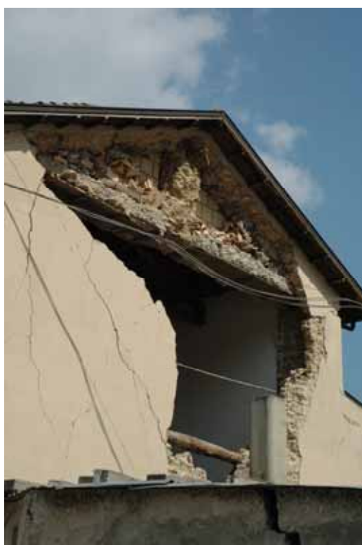
Figura 8. Crollo per ribaltamento fuori dal piano di parete perimetrale (by A. Balsamo, I. Iovinella, A. Prota)
