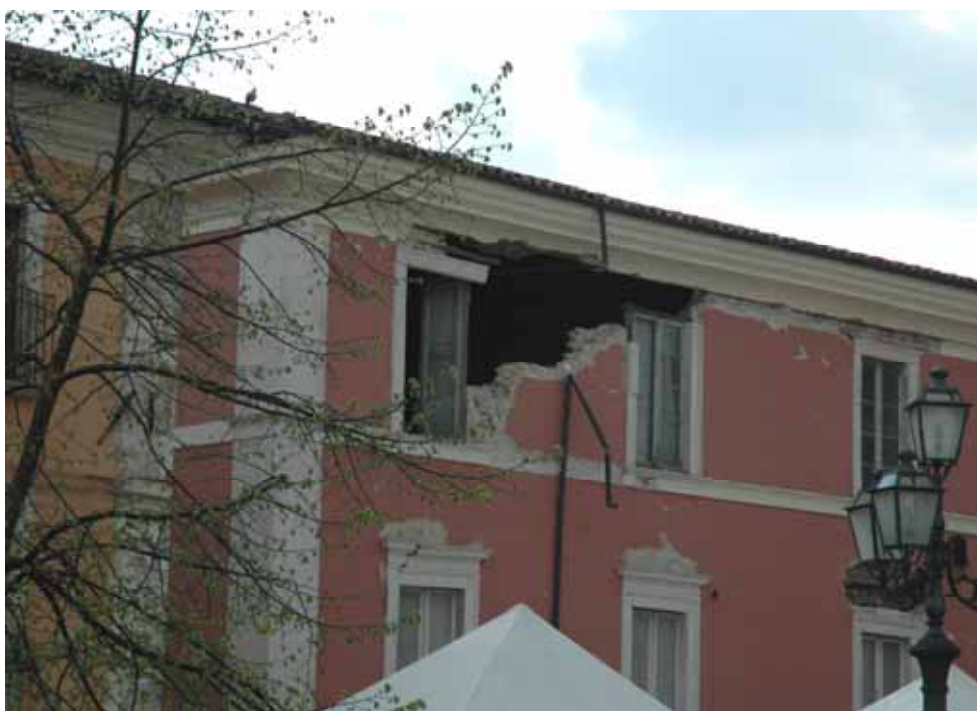
Figura 7. Crollo per ribaltamento fuori dal piano di pannello murario di sommità (by A. Balsamo, I. Iovinella, A. Prota)
