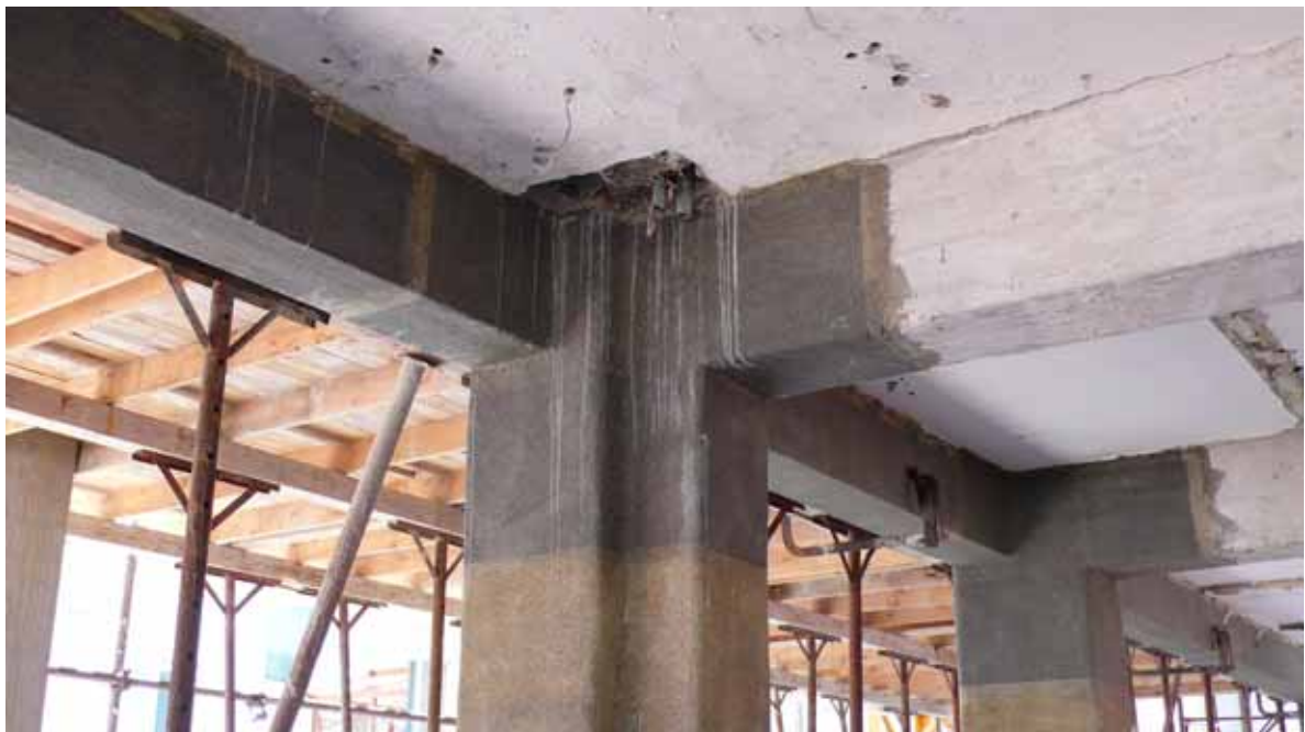
Figura 91. Rinforzo a taglio continuo con compositi di una trave interna in c.a. con fioccatore di ancoraggio
