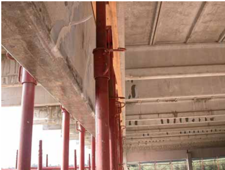
Figura 80. Rinforzo a flessione con compositi di una trave in c.a.
