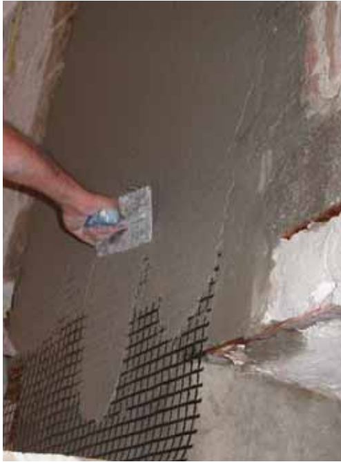
Lisciatura della superficie " fresca " con spatola piana.
