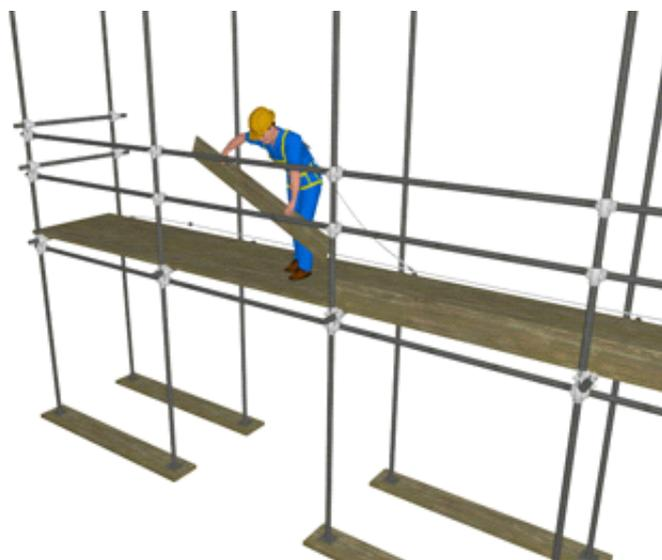
Step B: Il lavoratore in quota, mediante "passamano", passerà ai lavoratori a terra gli elementi del ponteggio smontati.
