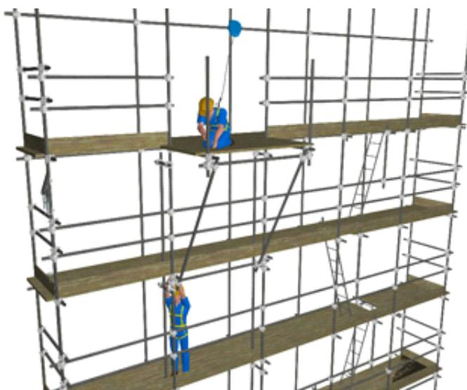
Step D: Il lavoratore in quota, terminerà il montaggio della piazzola montando i correnti parapetto e la tavola fermapiede.
