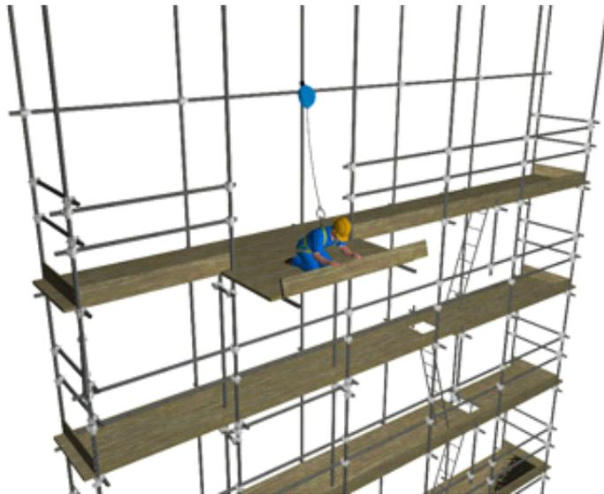
Step C: Il lavoratore in quota, aiutato dal lavoratore posto al piano inferiore, monterà gli elementi della piazzola nel seguente ordine: montanti, corrente esterno, puntoni, diagonali.
