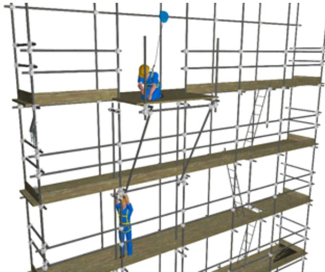
Step B: Il lavoratore in quota, agganciato al DPI anticaduta, smonterà le tavole della piazzola partendo da quelle esterne; una volta tolte le tavole si porterà sull'impalcato inferiore sganciando il DPI anticaduta solo dopo essersi posizionato sulle scale per la discesa.
