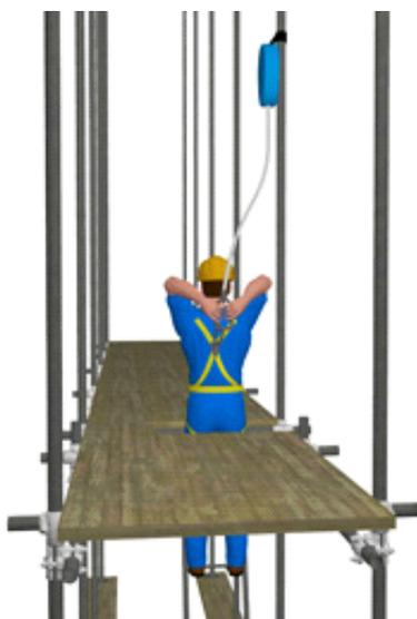
Step D: I lavoratori, mediante "passamano", passeranno al lavoratore in quota gli elementi del ponteggio da montare.
