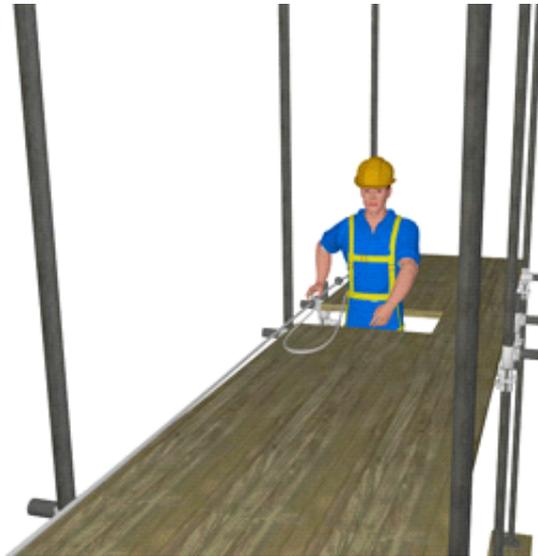
Step D: I lavoratori, mediante "passamano", passeranno al lavoratore in quota gli elementi del ponteggio da montare.
