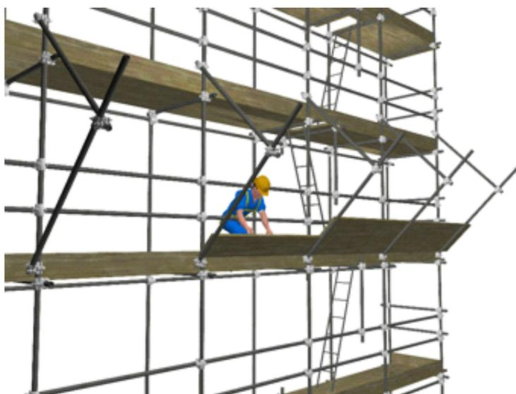
Step D: Per posizionare l'ultima fila di tavole il lavoratore in quota dovrà agganciare, in posizione verticale, il DPI anticaduta retrattile al punto di ancoraggio, quindi, oltrepassare il parapetto e montare le tavole.
