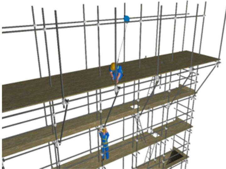
Step B: Il lavoratore in quota, agganciato al DPI anticaduta, smonterà le tavole dello sbalzo partendo da quelle esterne; una volta tolte le tavole si porterà sull'impalcato inferiore sganciando il DPI anticaduta solo dopo essersi posizionato sulle scale per la discesa.
